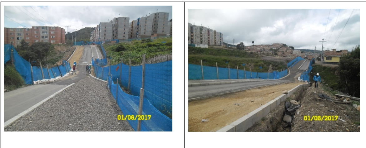
Librada, vía vehicular provisional existente.
