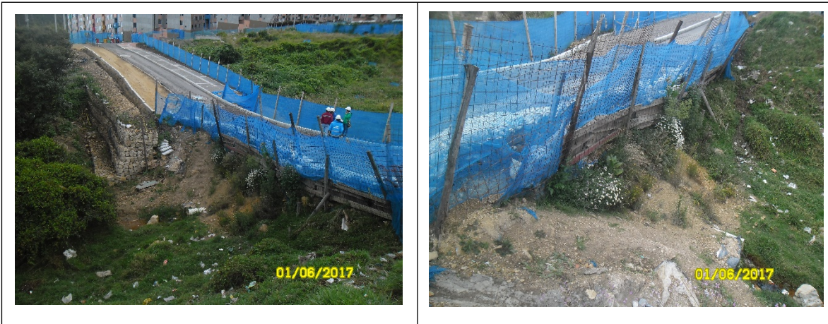
Librada, vía vehicular provisional existente.
